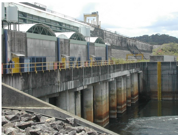
Barrage hydroélectrique de Petit Saut
